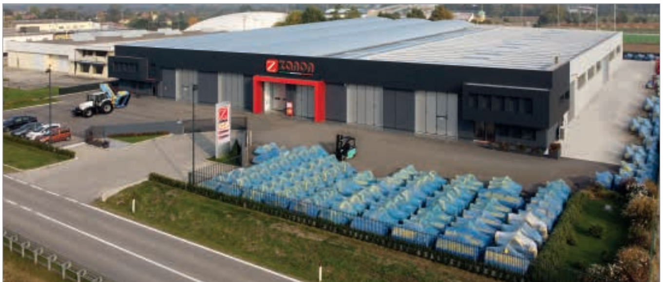
PRODUCTION FACILITY AND WAREHOUSE Sede prod. e magazzino di Campodarsego (via Antoniana, 286)
